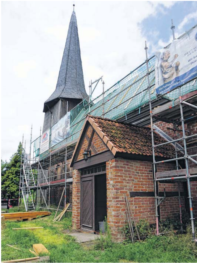
Das Dach ist noch abgedeckt. Die noch guten alten Dachziegel kommen auf den kleinen Anbau. FOTOS (4): MARTINA SCHWENK
