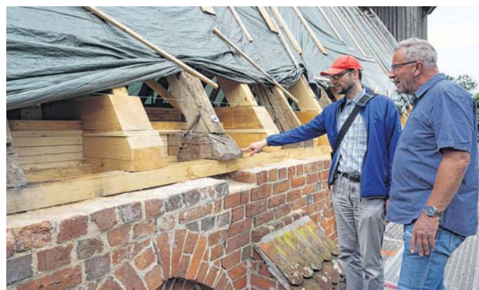
Pastor Giebel zeigt Focko Weberling die Kombination aus altem und neuem Dachstuhl.
