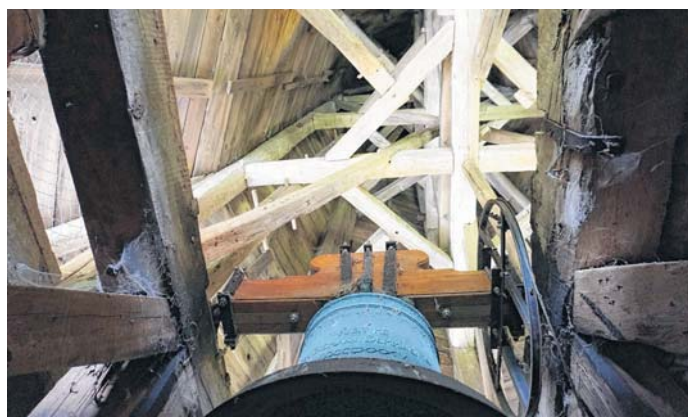
Die alte Glocke und der Dachstuhl des Turms hat die Besucher in ihren Bann gezogen.
