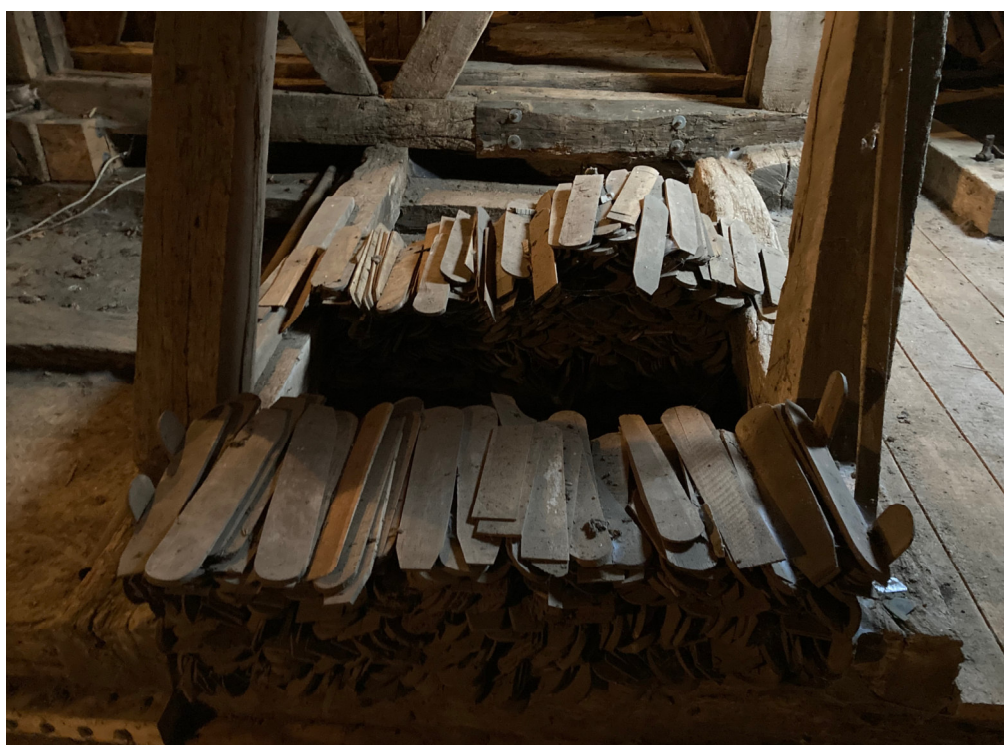
Alte Holzschindeln, die für die Kirchturmeindeckung verwendet wurden
