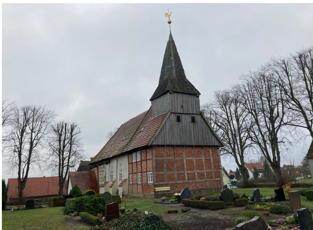
Ansicht von Nordwest auf den schindelgedeckten Kirchturm
